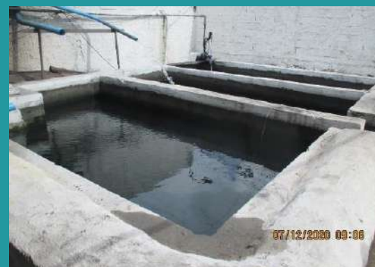
Caixa separadora de água e óleo
