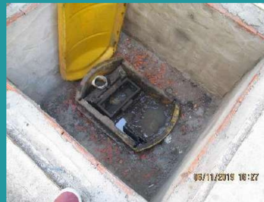
Caixa separadora de água e óleo
