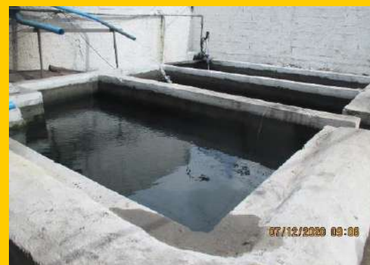
Caixa separadora de água e óleo
