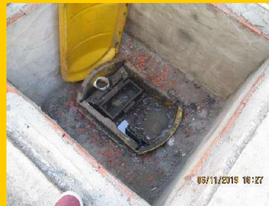
Caixa separadora de água e óleo
