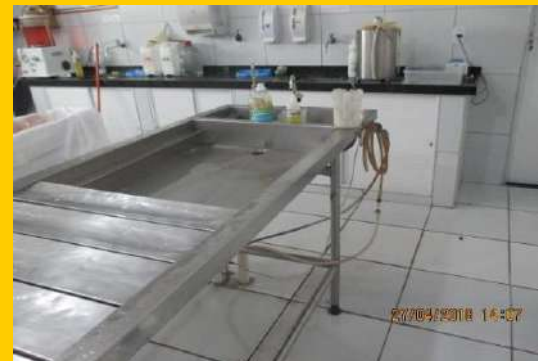
ETE de lavanderia
