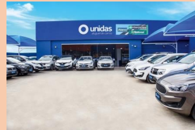
Área da edificação + pátio de carros
