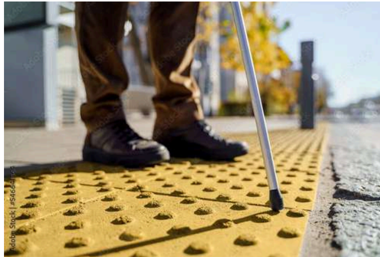
Figura 45 – Sinalização tátil direcional em piso com faixa lateral com piso liso complementa
