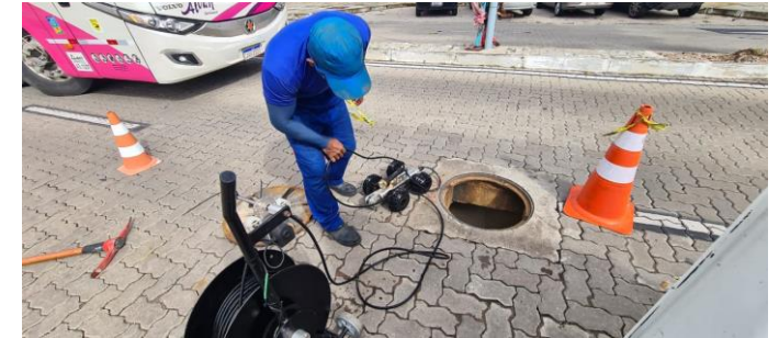
Vídeo inspeção das galerias
