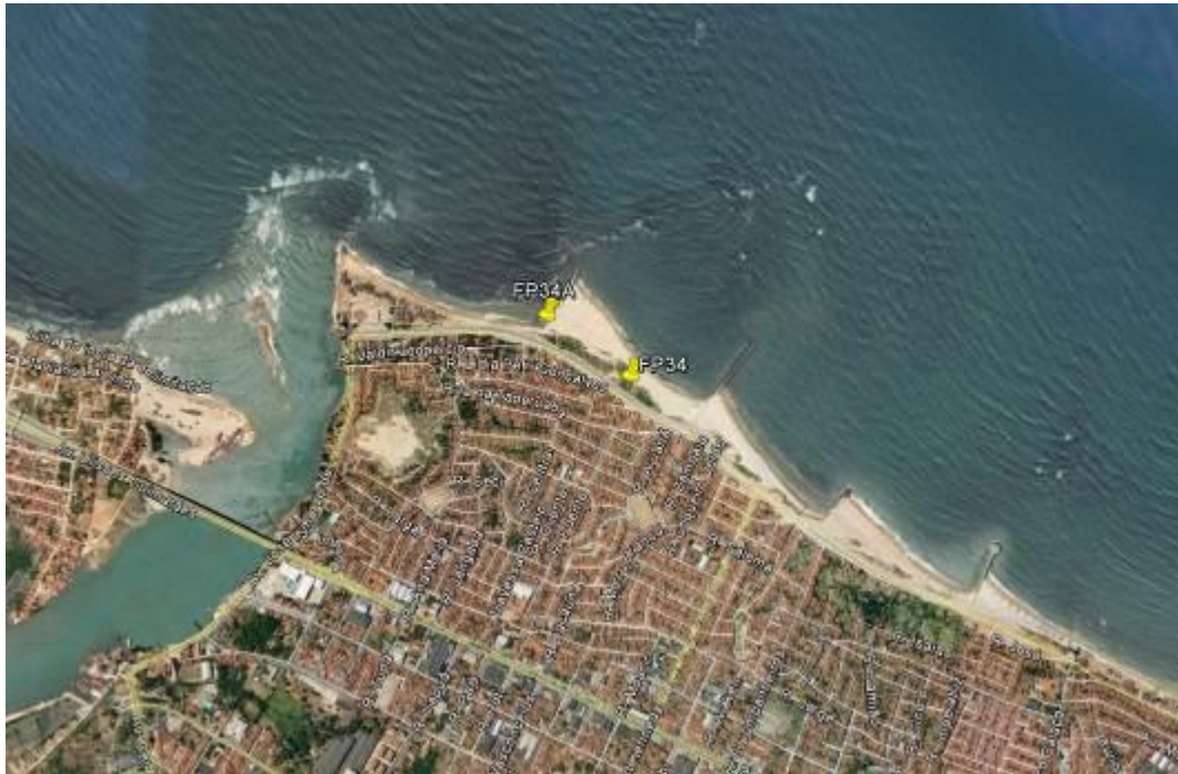
FIGURA 5: GALERIAS FP 34A E FP 34 NO DETALHE
