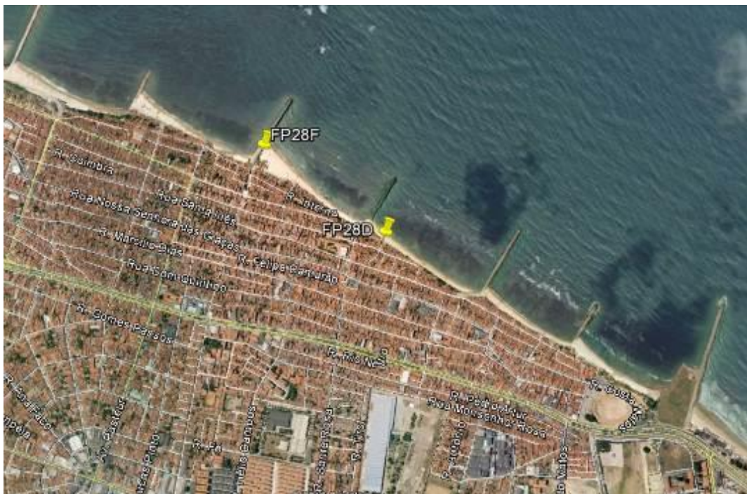
FIGURA 6: GALERIAS FP 28F E FP 28D NO DETALHE
