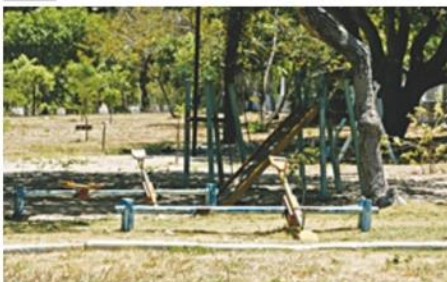
Obras no Parque Adahil Barreto devem começar até o fim do ano, segundo o prefeito. O equipamento sofre com a falta de manutenção. FOTO: NATINHO RODRIGUES
