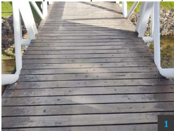
Painel 9 – Mapeamento das pontes com identificação dos pontos.
