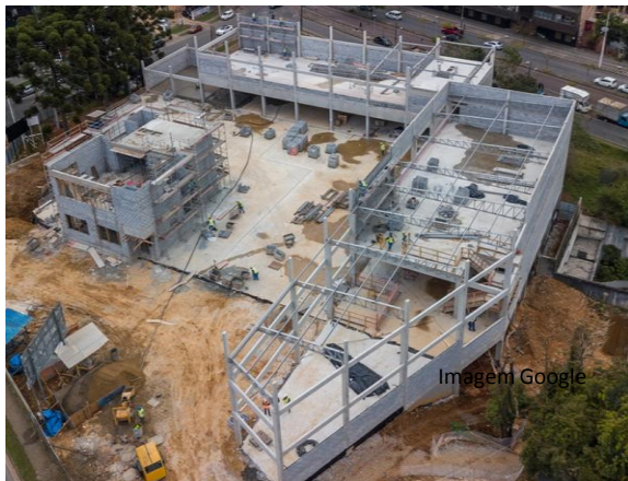
C. Canteiro de obra
