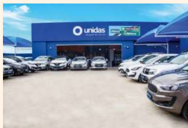
Área da edificação + pátio de carros
