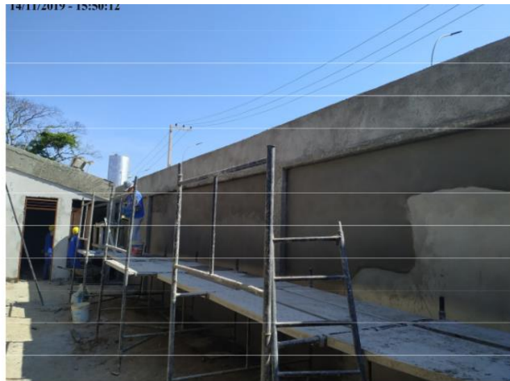
Execução de reboco no Bloco Educacional
