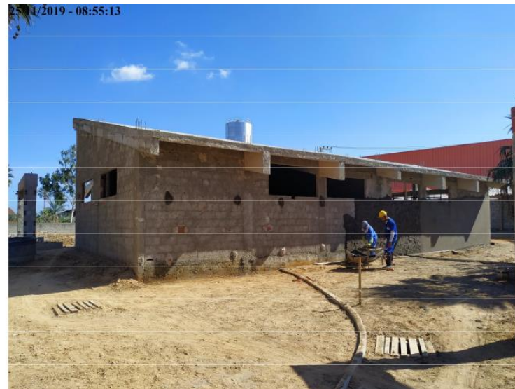
Execução de reboco no vestiário
