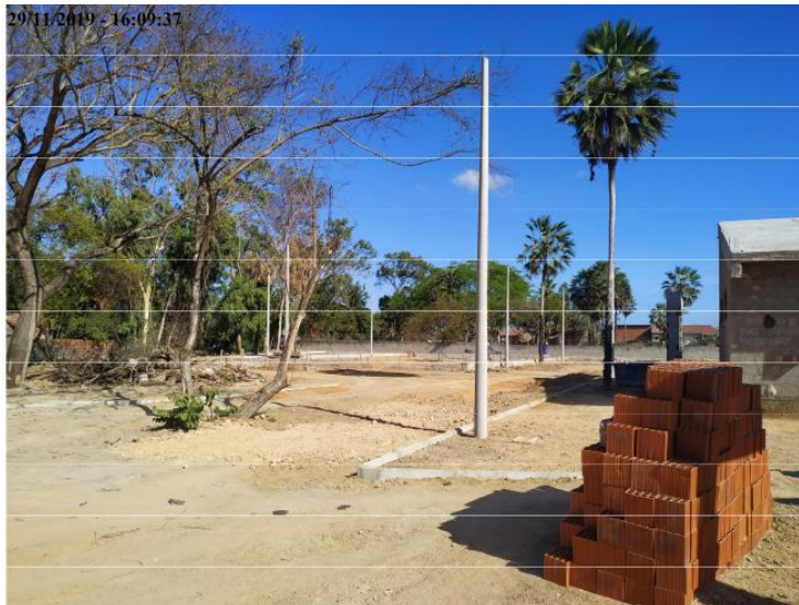
Execução de postes de concreto na obra
