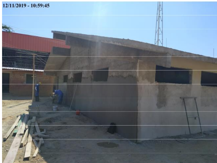
Execução de reboco no Bloco Educacional
