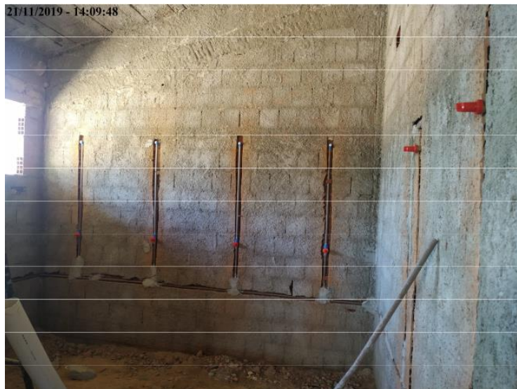
Execução de instalações hidráulicas no vestiário
