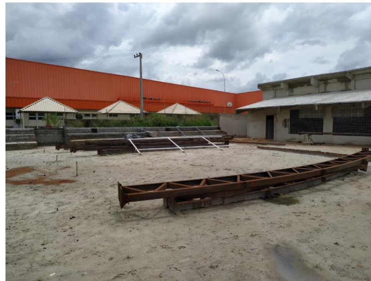
Execução de estrutura metálica da Quadra Coberta
