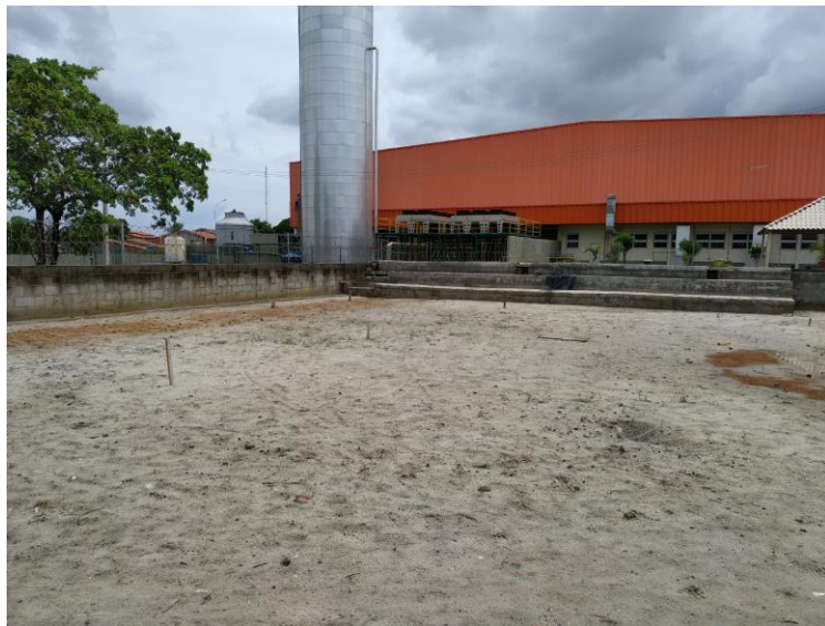
Execução de aterro para Quadra Coberta
