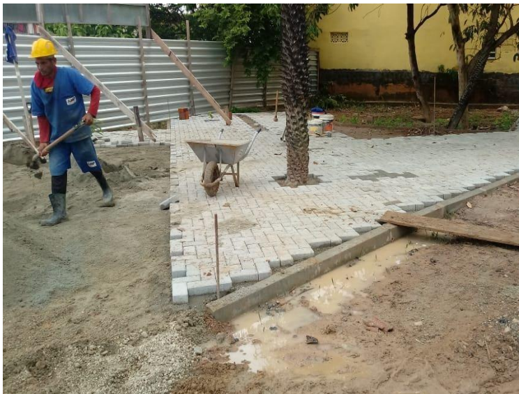
Execução de piso intertravado
