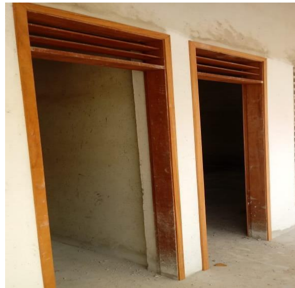
Execução de portas de madeira
