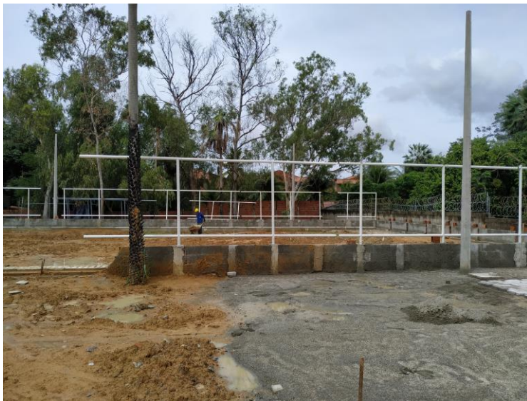
Execução de lastro de pó de pedra para intertravado
