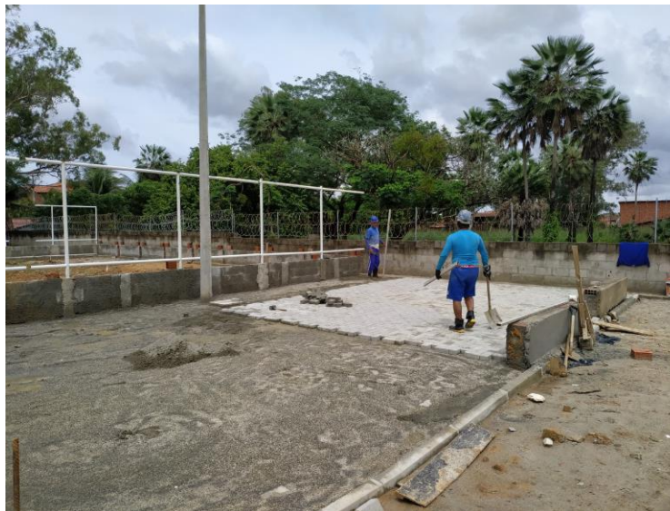
Execução de piso intertravado
