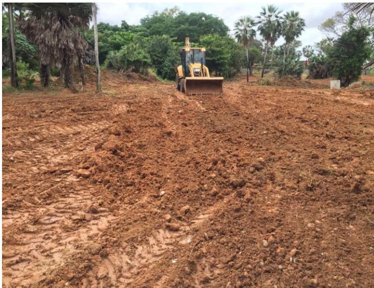
Raspagem e limpeza do terreno
