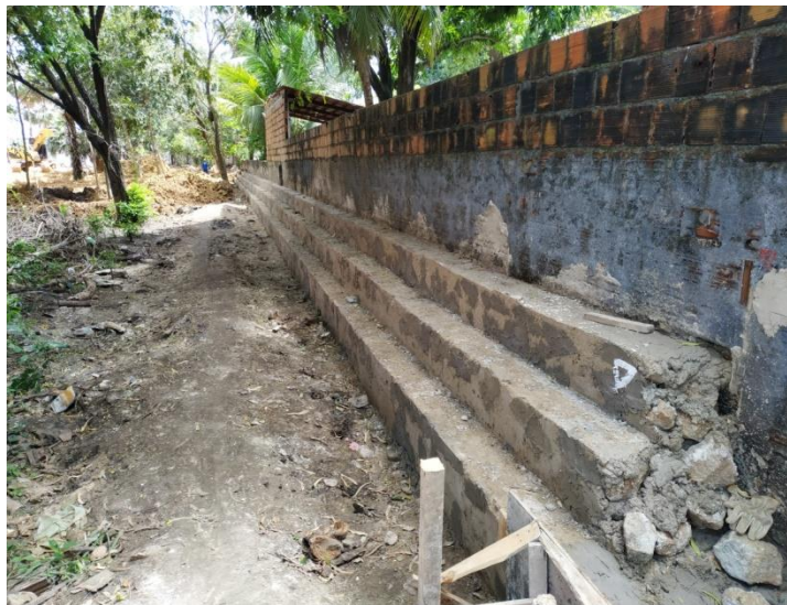
Execução do muro de arrimo em pedra argamassada
