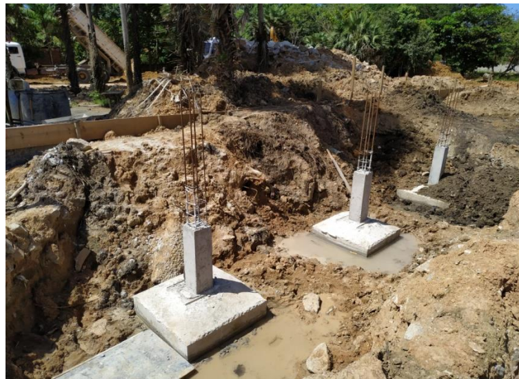
Concretagem de sapatas e pilares
