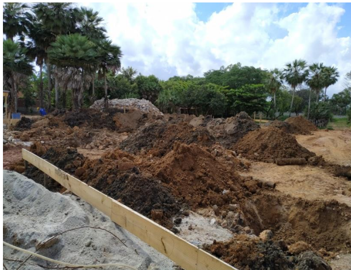
Execução da escavação do Bloco educacional
