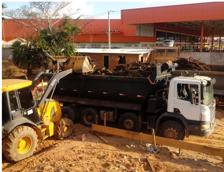
Remoção e transporte de camada vegetal
