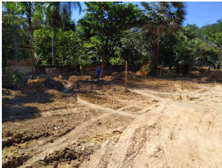
Espalhamento e compactação de material de aterro
