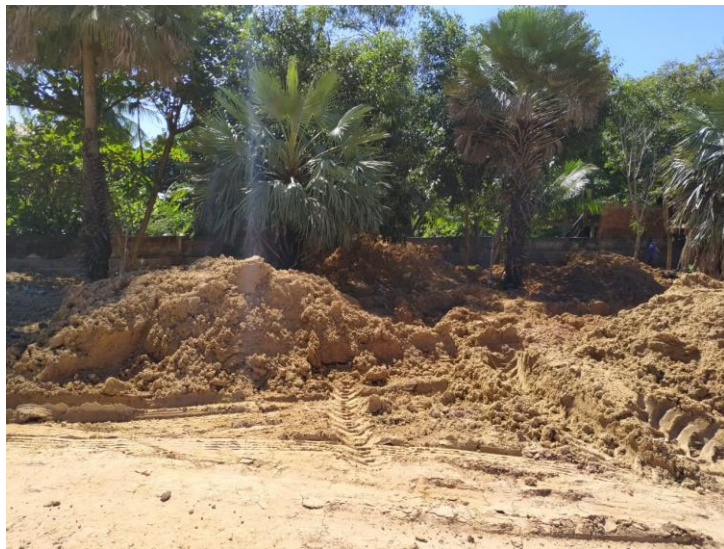
Amontoamento de material de aterro
