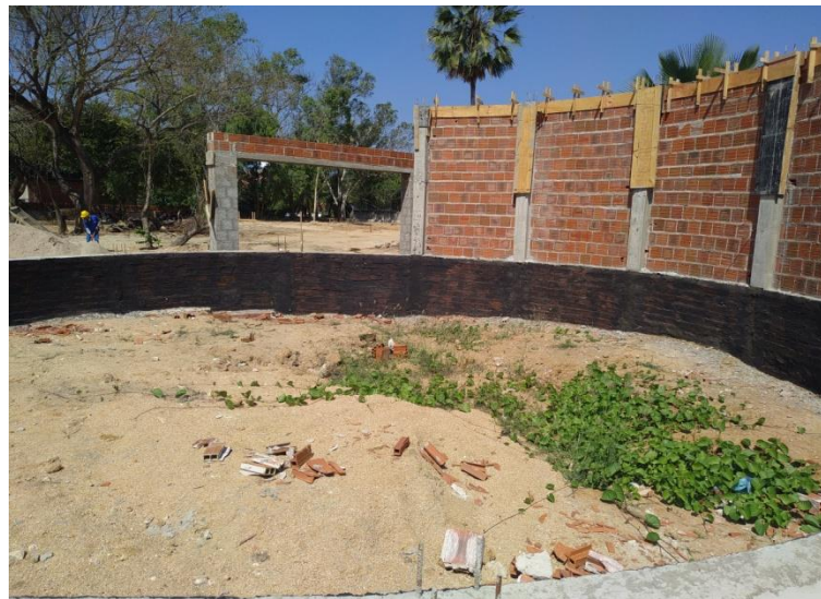
Execução de impermeabilização do palco do anfiteatro
