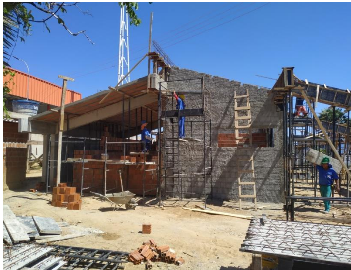
Execução de chapisco em alvenaria
