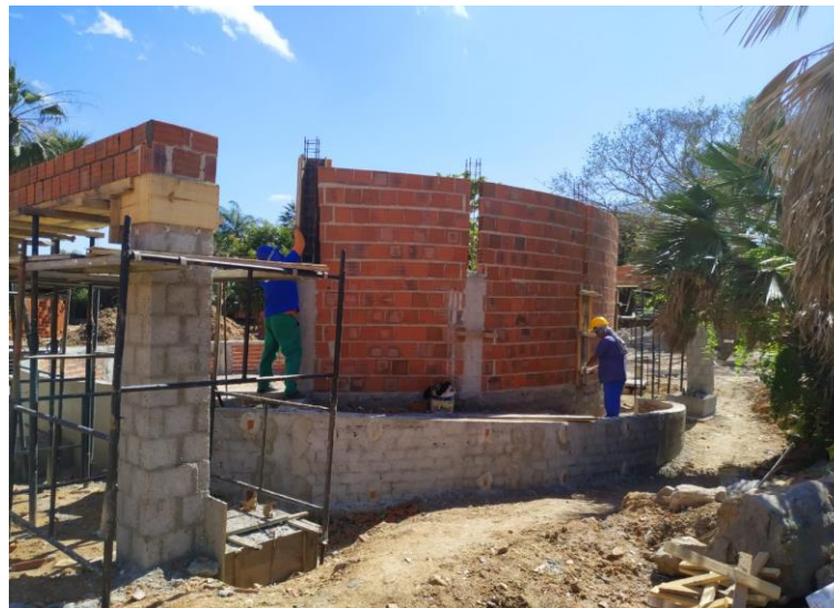
Execução de fôrmas e alvenarias do anfiteatro
