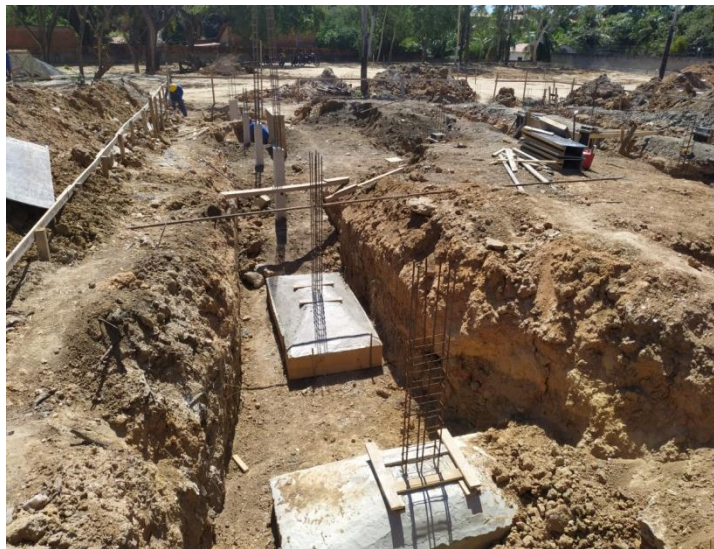
Execução das fundações do vestiário
