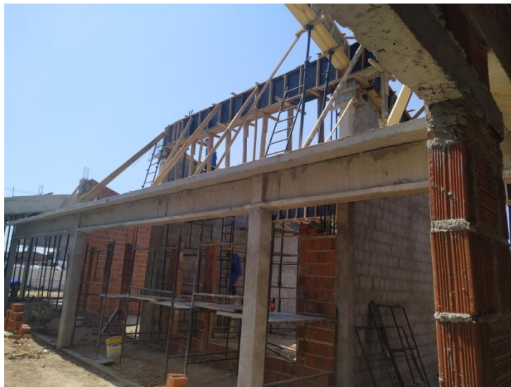
Execução de vigas em concreto
