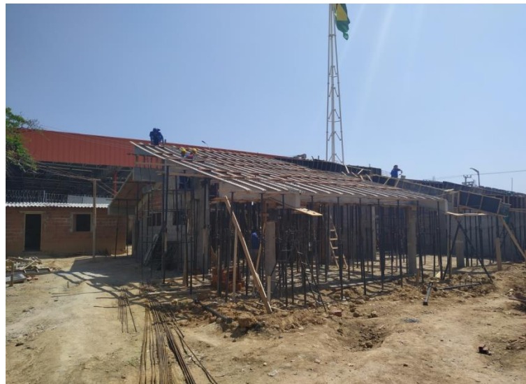
Execução de laje treliçada
