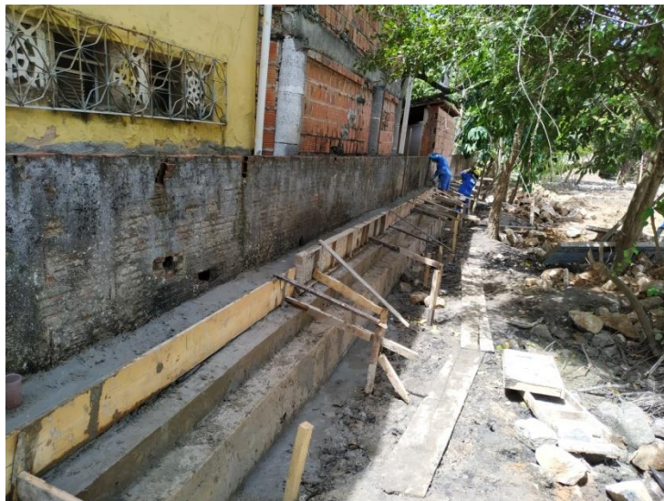
Muro de arrimo em pedra argamassada
