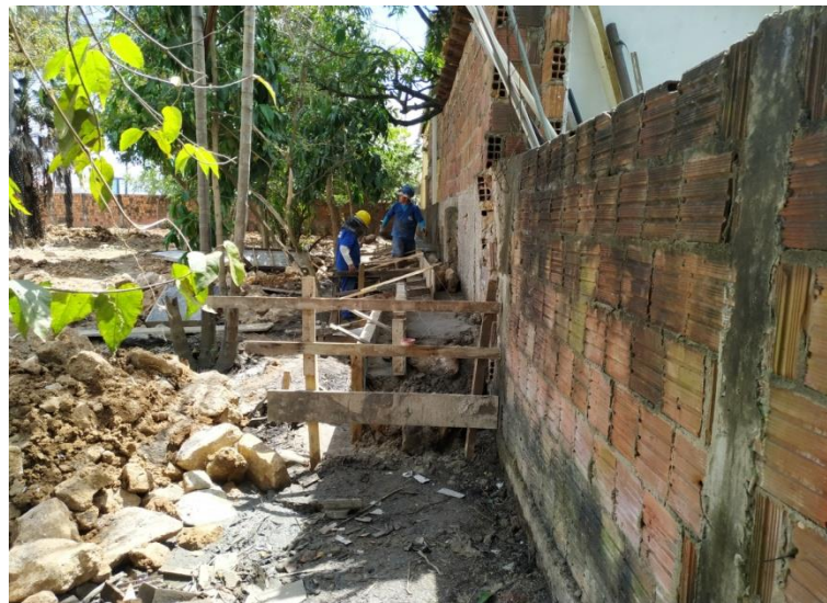
Fôrma para muro de arrimo
