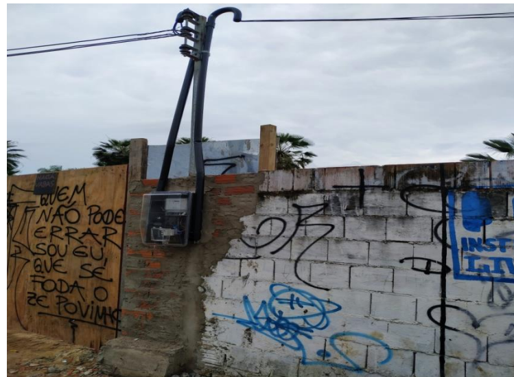
Ligação provisória de luz
