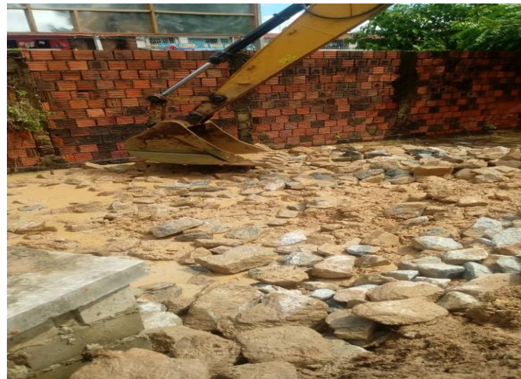
Compactação de base em pedra para reforço de solo
