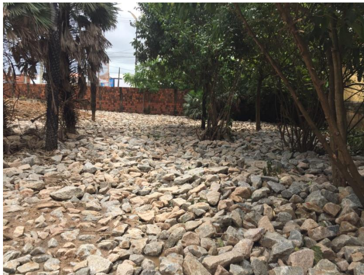
Execução da base para reforço do solo
