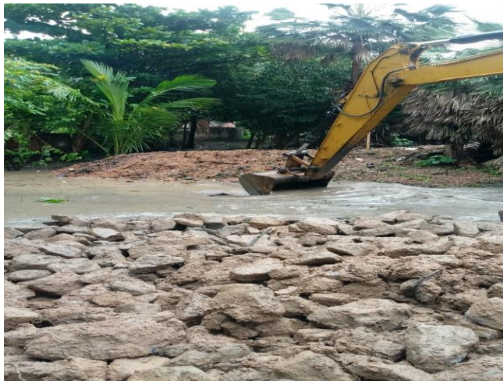
Expurgo de material para a execução da base em pedra
