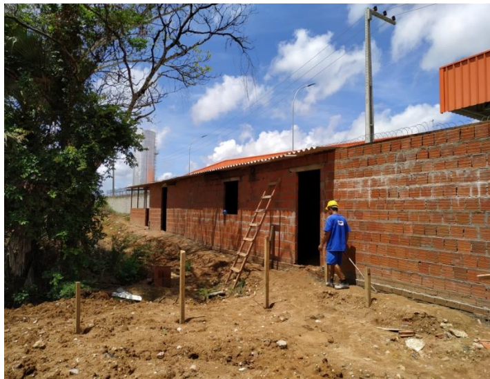
Execução do barracão
