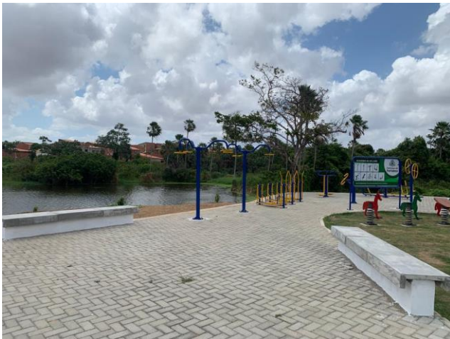
Figura 25 – Pavimentação de piso intertravado, banco de concreto e academia ao ar livre
