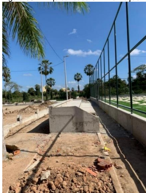
Figura 06 – Arquibancada em finalização
