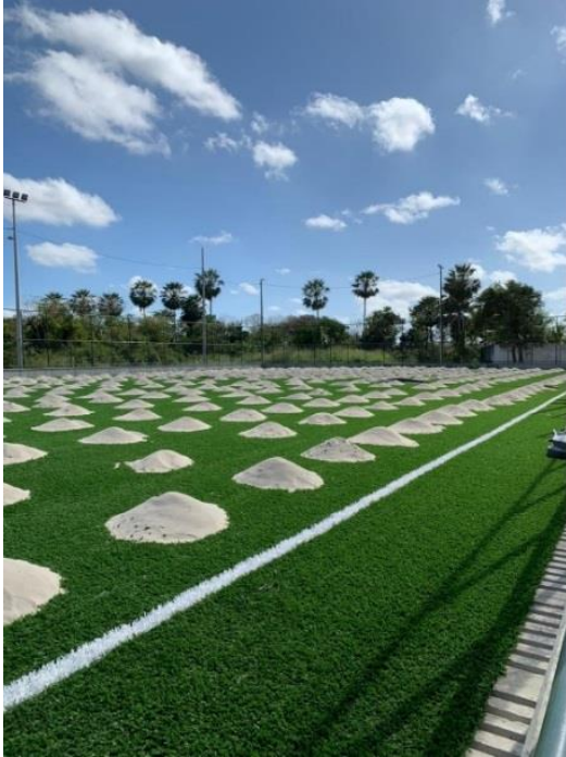
Figura 03 - Espalhamento de areia para grama sintética
