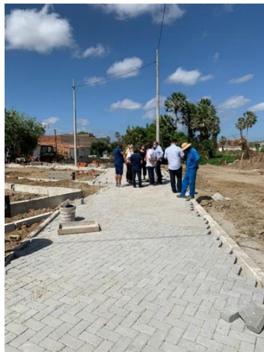
Figura 04 – Assentamento de intertravado
