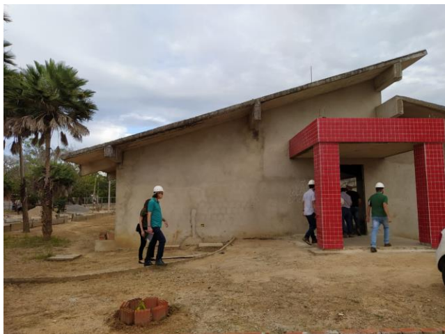
Imagem 1 – Fachada frontal do Bloco Educacional (junho/2020) Fonte: AMP Engenharia Eireli (2020)
