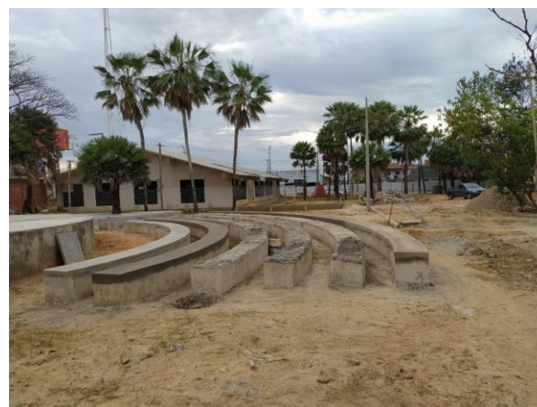
Imagem 4 – Anfiteatro (junho/2020) Fonte: AMP Engenharia Eireli (2020)
