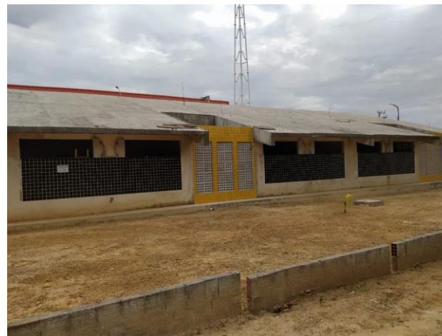
Imagem 1 – Fachada frontal do Bloco Educacional (junho/2020) Fonte: AMP Engenharia Eireli (2020)
