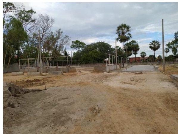
Imagem 8 – Quadra poliesportiva (junho/2020) Fonte: AMP Engenharia Eireli (2020)
