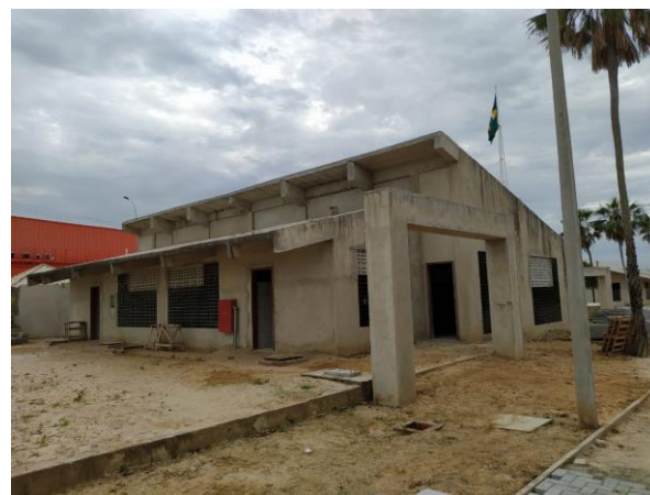
Imagem 6 – Vestiários (junho/2020) Fonte: AMP Engenharia Eireli (2020)
