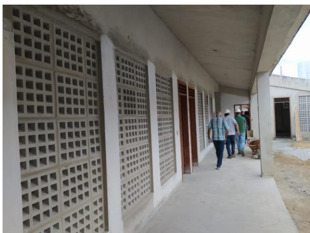
Imagem 3 – Interior do Bloco Educacional (junho/2020). Fonte: AMP Engenharia Eireli (2020)
