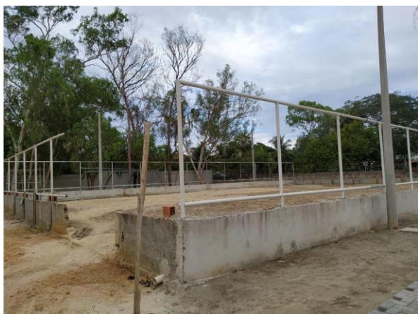
Imagem 7 – Quadra poliesportiva (junho/2020) Fonte: AMP Engenharia Eireli (2020)
