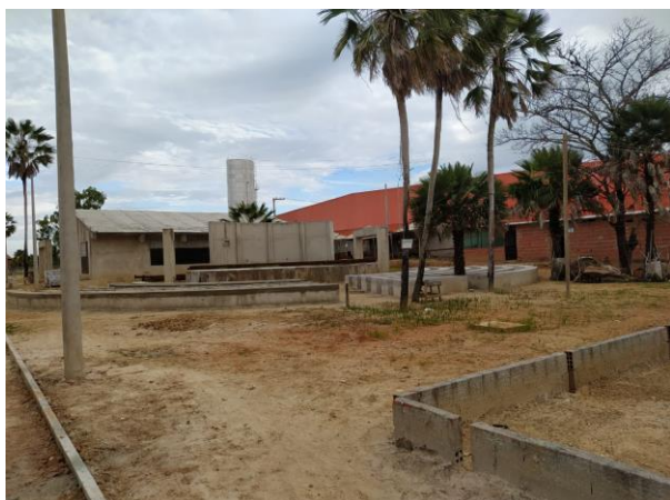
Imagem 5 – Anfiteatro (junho/2020) Fonte: AMP Engenharia Eireli (2020)
