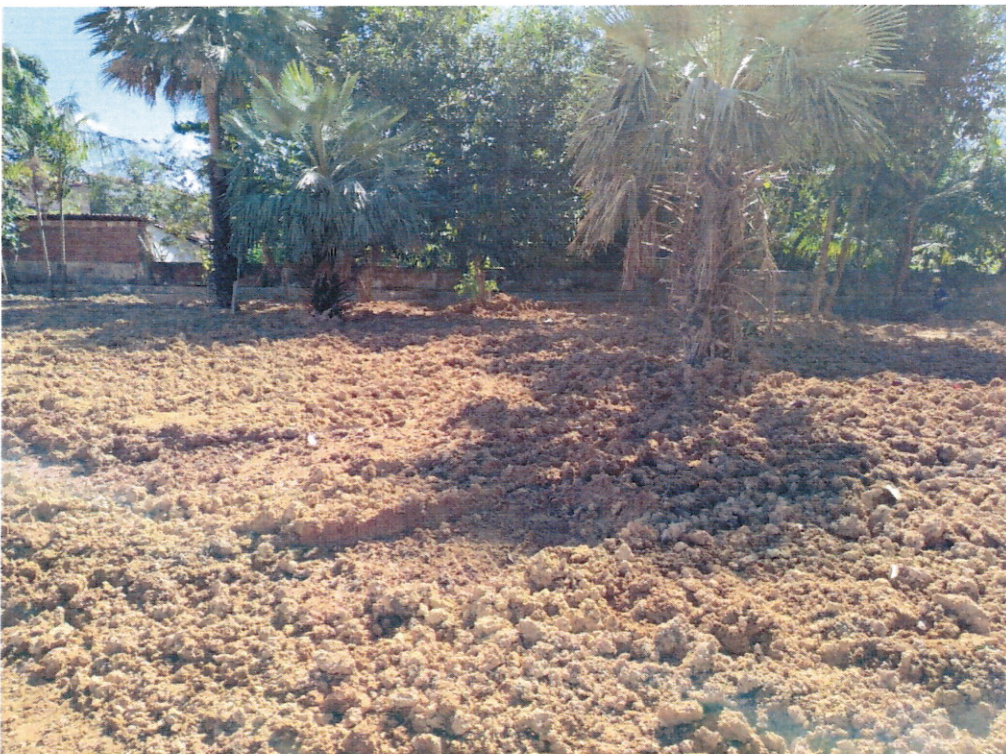
Foto: Execução de camadas de aterro, DATA: 30/05/2019
