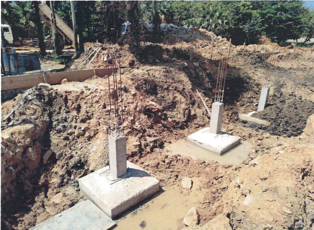
Foto: Concretagem de Sapatas e Pilares do Bloco Educacional, DATA: 15/05/2019
