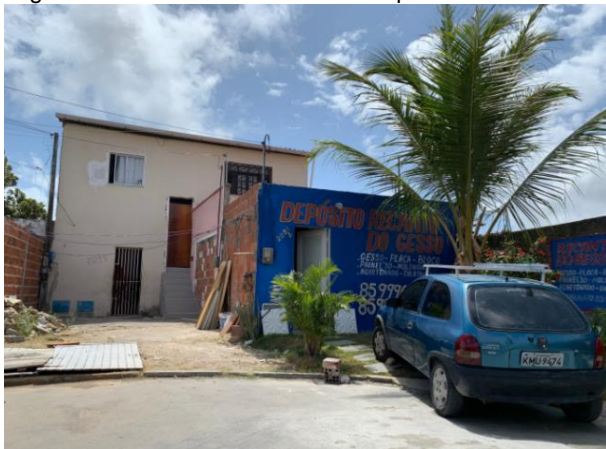
Figura 14 – Casa construída em via pública
