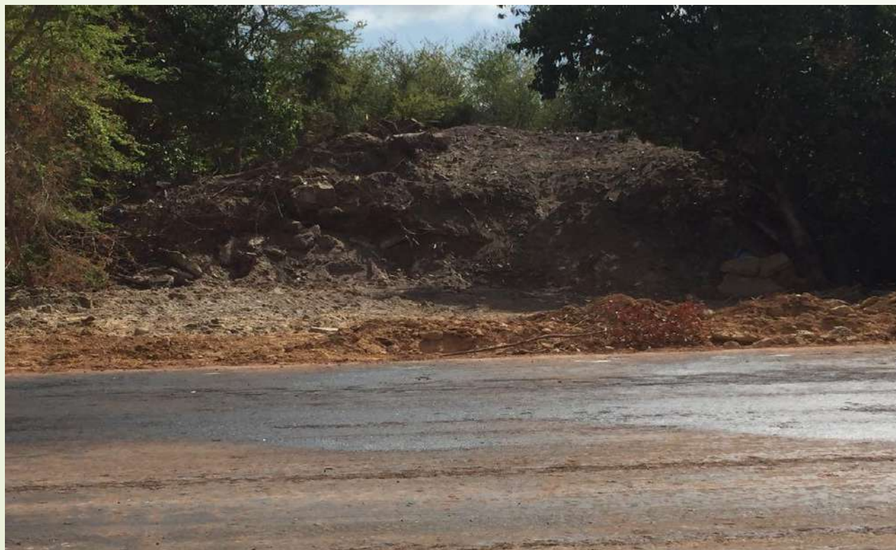
Figura 01: Entulho depositado aguardando retirada.
