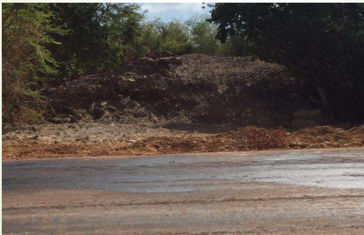
Figura 01: Entulho depositado ainda a ser retirado.
