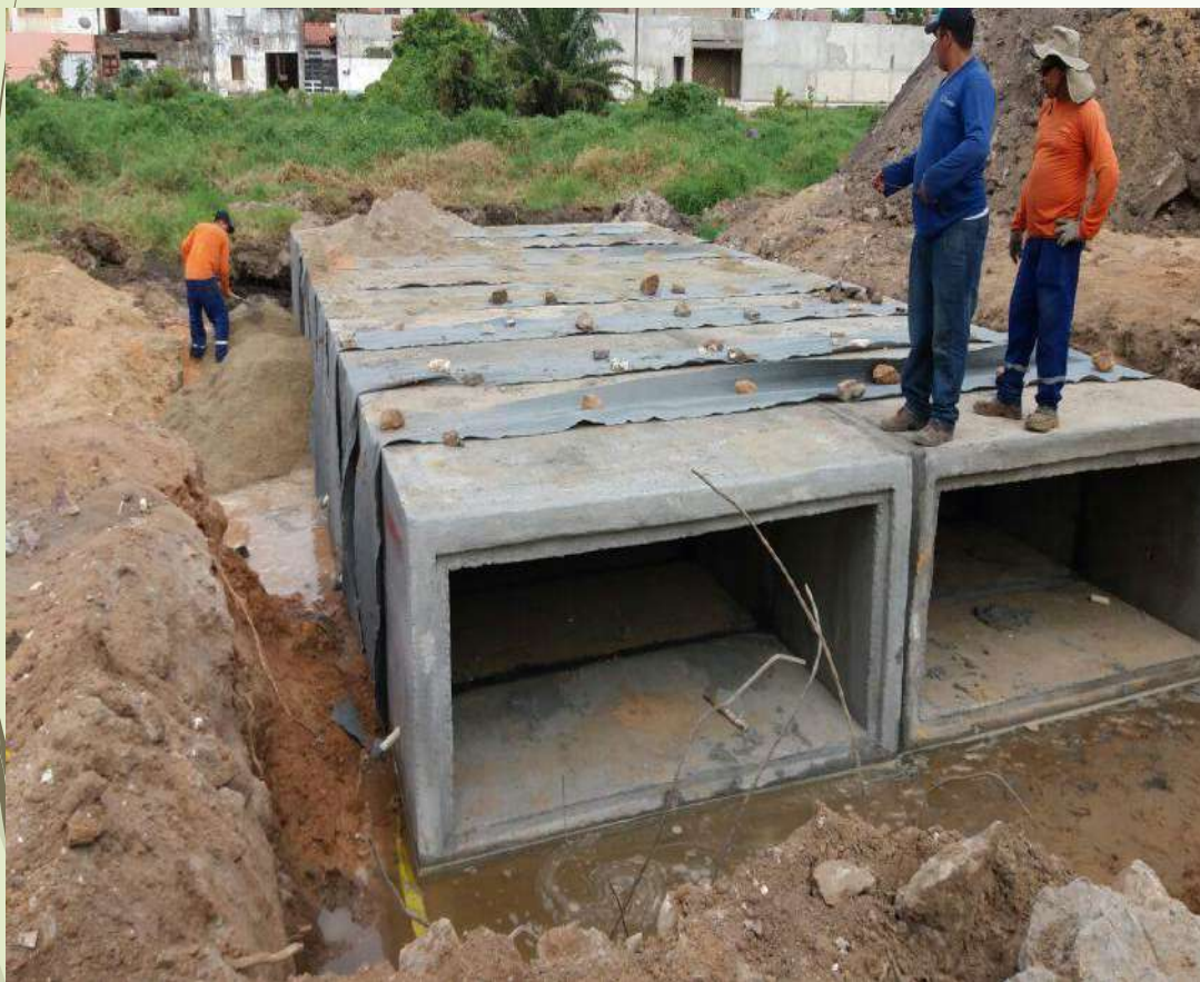
Figura 16. Aplicação da manta bidim RT-14.
