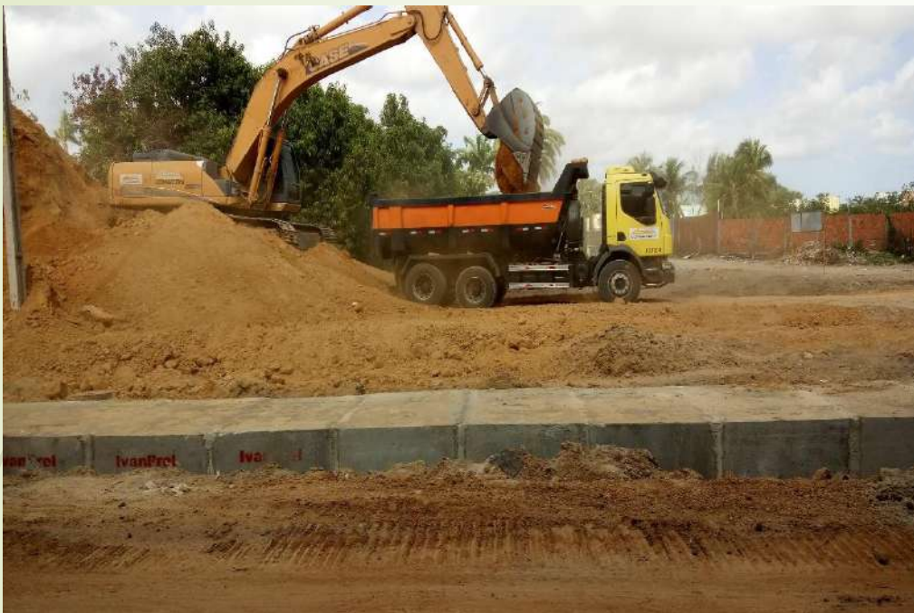
Figura 13. caçamba encostando material
