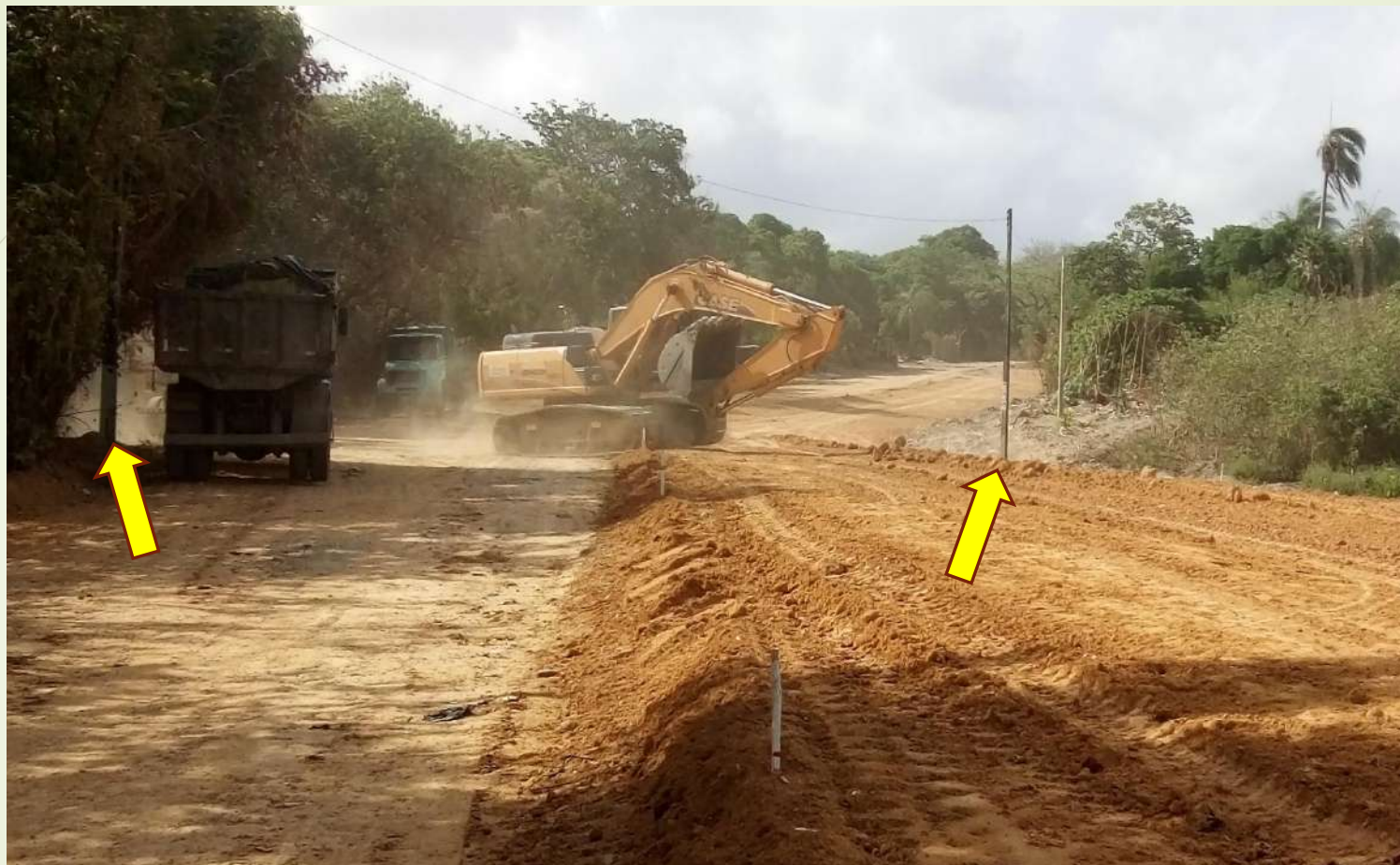
Figura 12. portes substituídos pela Anel
