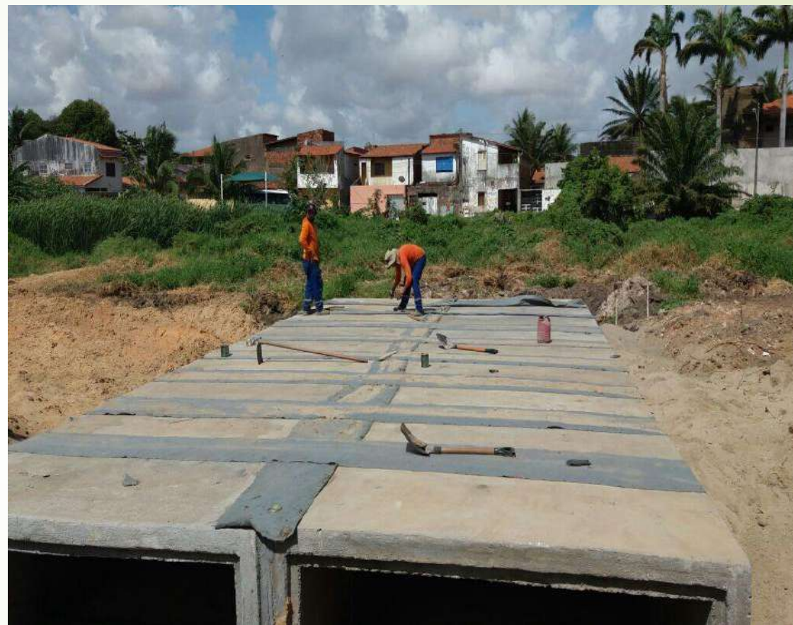
Figura 17. Processo de colagem da manta bidim RT-14.
