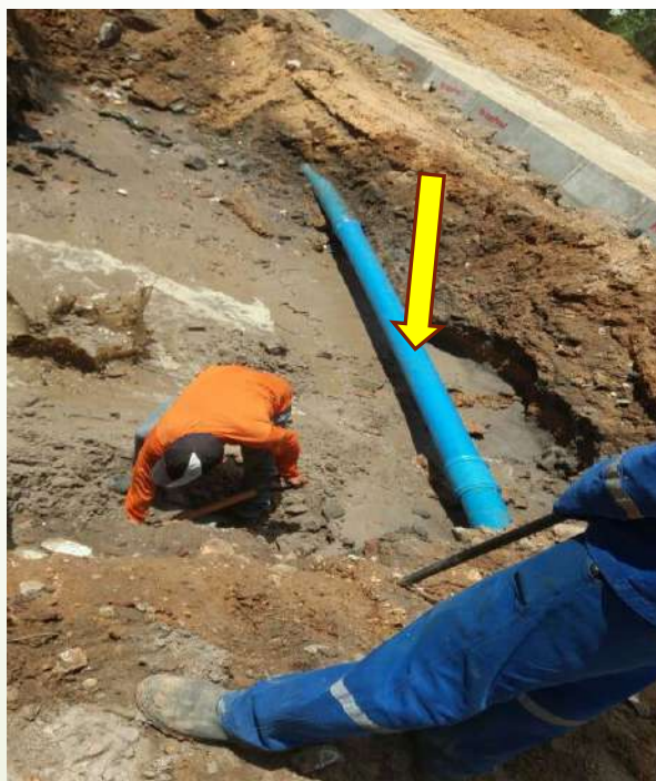
Figura 07. Adutora de Água
