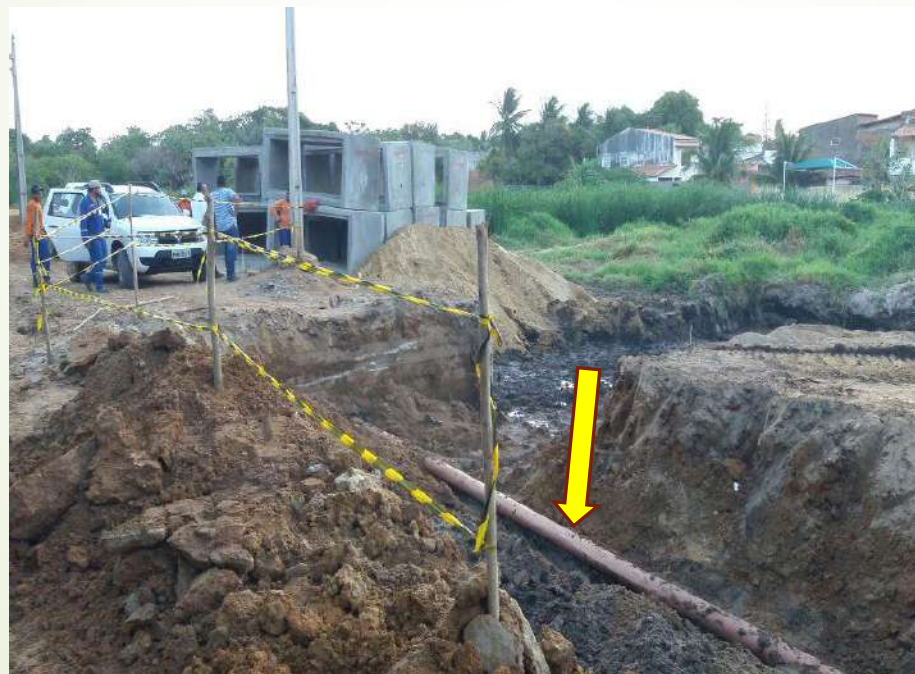
Figura 06. Tubos de esgoto
