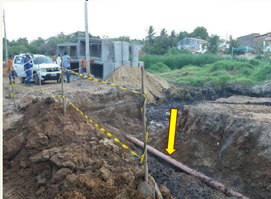
Figura 03. Tubos de esgoto
