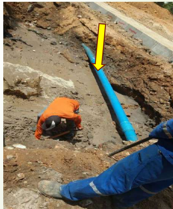
Figura 04. Adutora de Água
