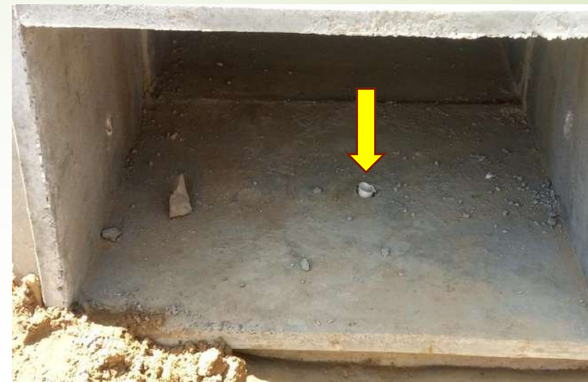
Figura 24. Instalação de barbacã no fundo dos pré-moldados da galeria de drenagem.
