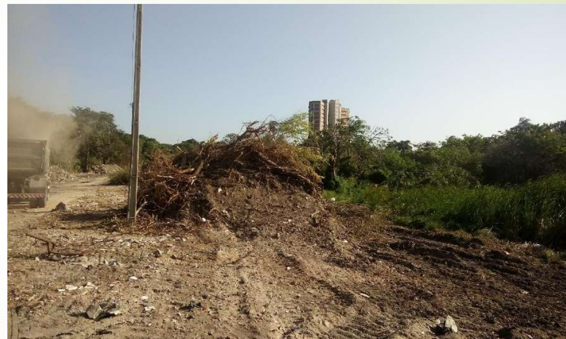
• Figura - 13 Limpendo e raspando o local da via:
