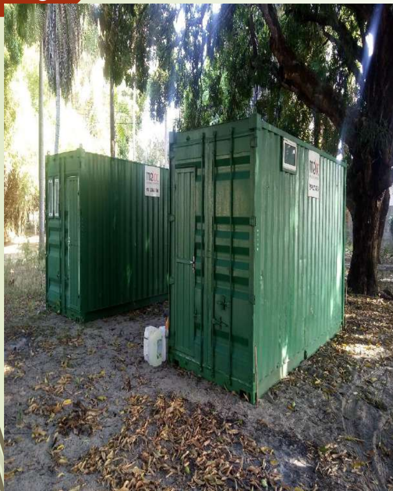
▪ Figura – 05 Instalações provisórias:
