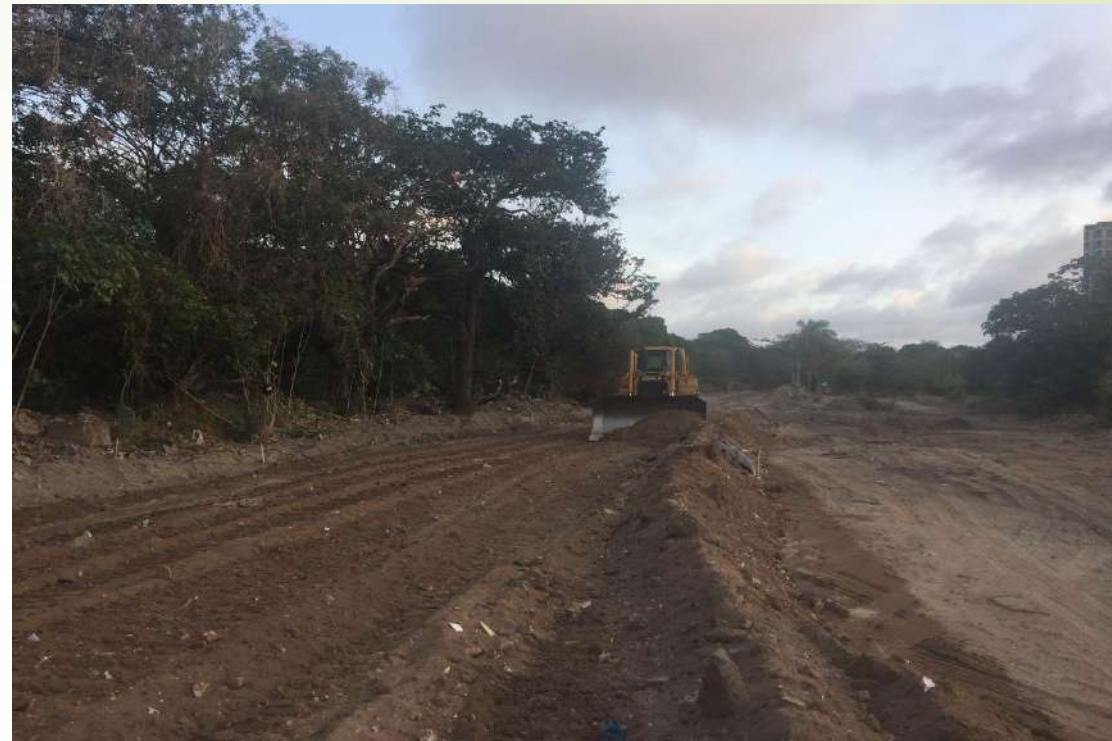
Figura 13. Lançamento de aterro estaca16 no lado direito
