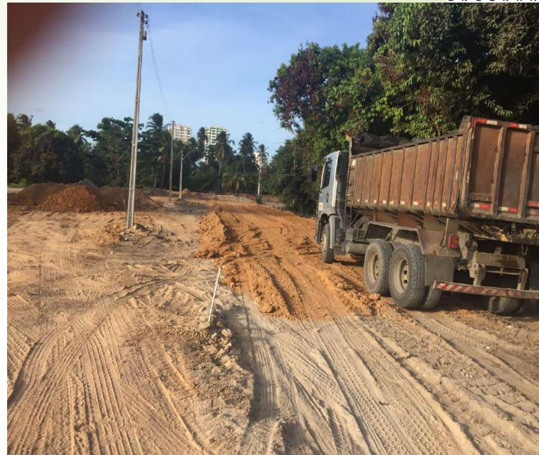
Figura 16. Lançamento de material lado direito da estaca 26 a 30
