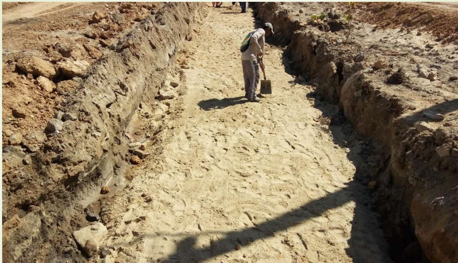
Figura 27. Execução de valas para assentamento de pré moldados de drenagem.
