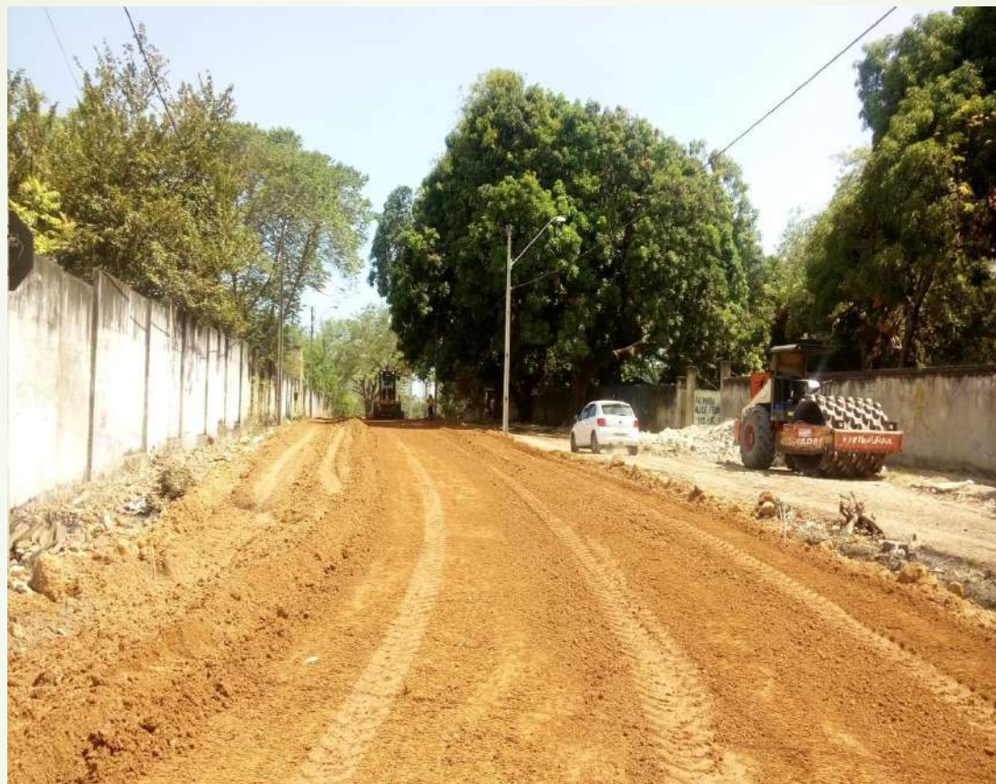
Figura 14. Camada de sub-base aplicada e compactada da estaca 01 a 05 do lado esquerdo da via
