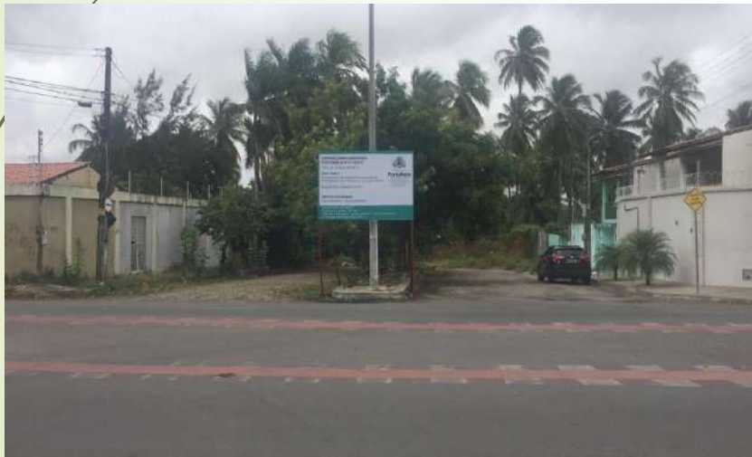
Figura 09. Placa de obra das vias – Extremidade Av. Léa Pompeu com Av. Norte
