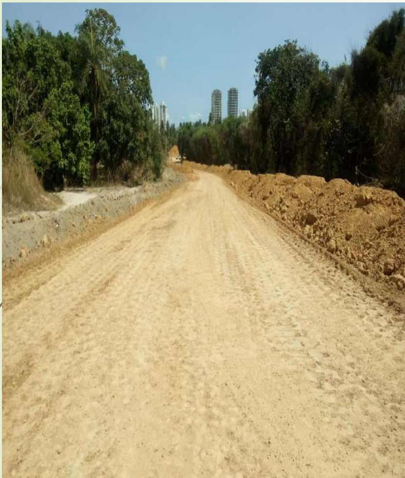
Figura 15. compactação da sub-base “pronta” das estacas 12 a 19 pronta, lado esquerdo da via.
