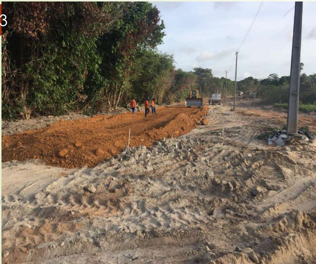
Figura 15. Lançamento de material lado direito da estaca 22 a 24
