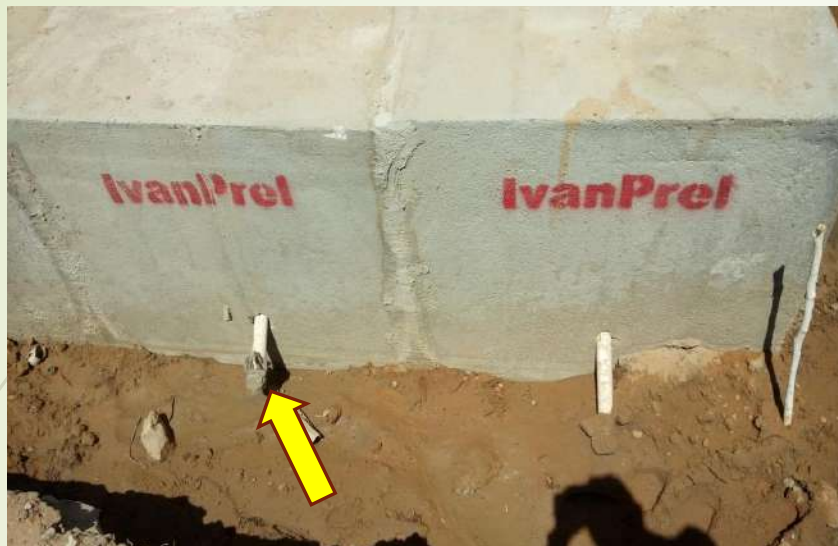
Figura 23. Instalação de barbacã nas laterais dos pré-moldados da galeria de drenagem.
