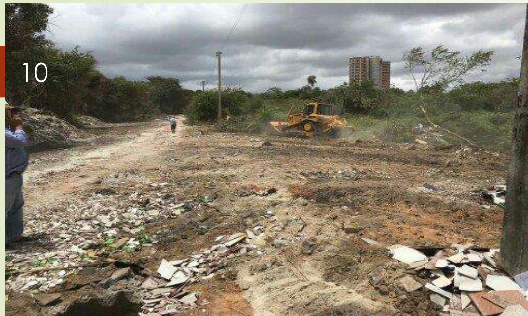
• Figura - 12 Início da raspagem do entulho
