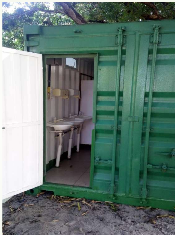
▪ Figura – 06 Instalações Vestiário e Wc
