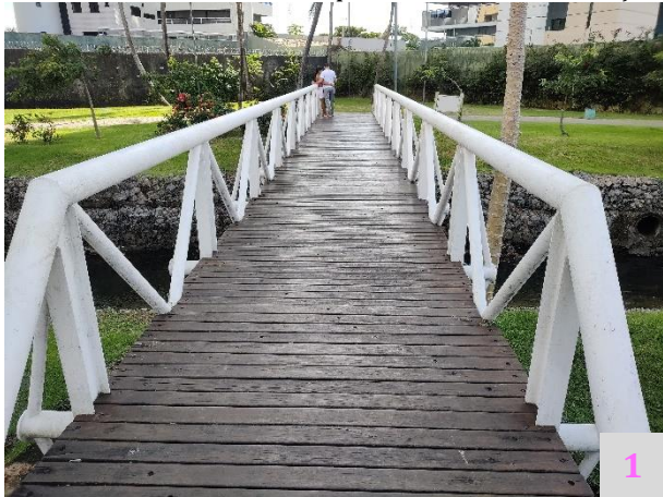
Painel 14 – Pontes com mapeamento de identificação dos pontos.
