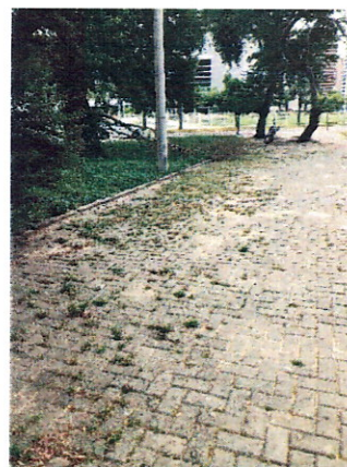
Vegetação entre os blocos. Precisa de manutenção.
