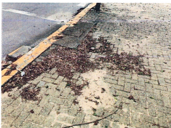
Peças irregulares e com resíduos. Precisa de manutenção.
