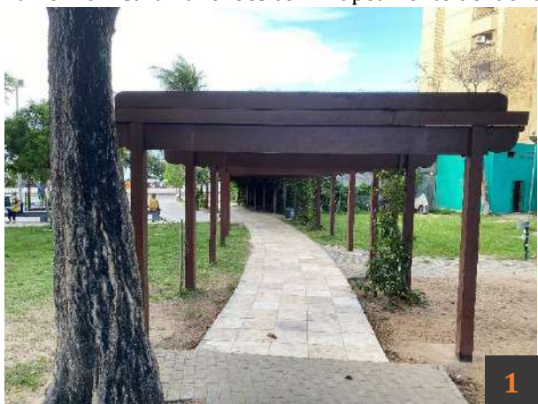
Painel 10 – Caramanchões com mapeamento de identificação dos pontos.
