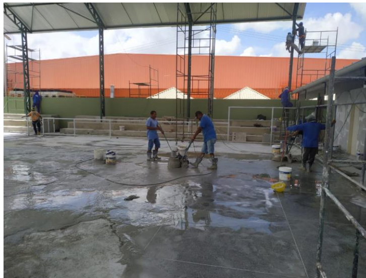
Execução do piso da quadra
