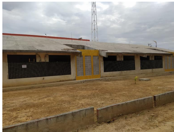
Fachada lateral do Bloco Educacional
