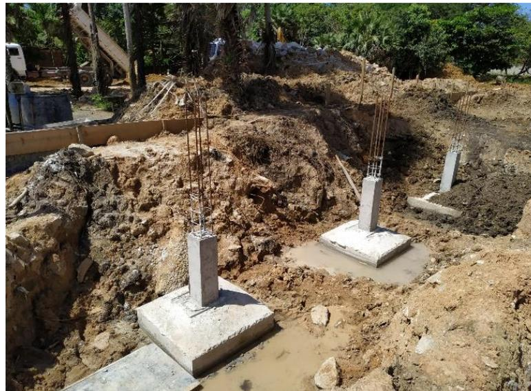
Concretagem de sapata e pilares. Data: 15/05/2019
