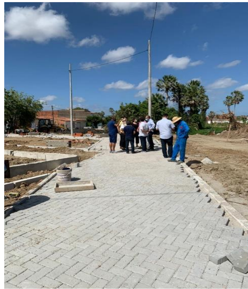
Assentamento de intertravado e meio fio pré moldado
