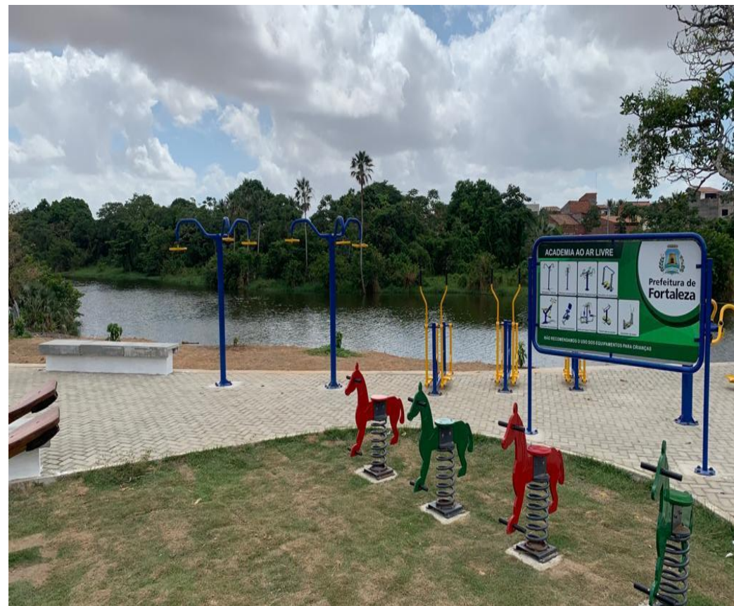
Pavimentação de piso intertravado, banco de concreto e academia ao ar livre
