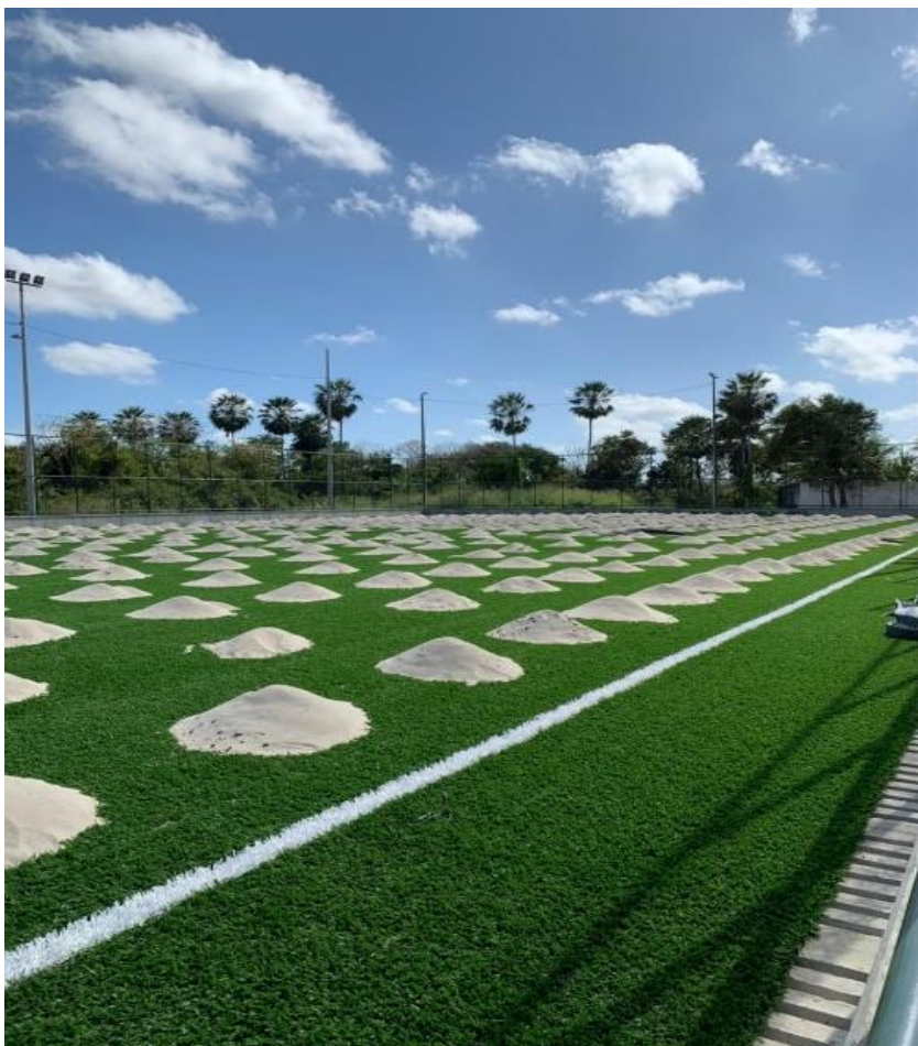
Espalhamento de areia grossa para execução da grama sintética
