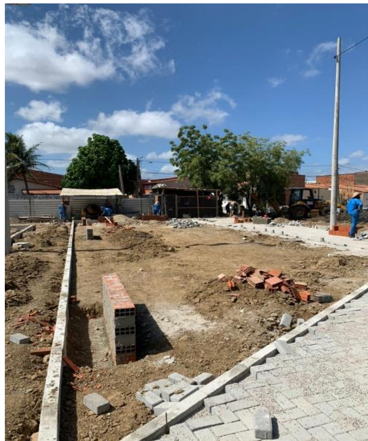
Colocação de tela no gradil
