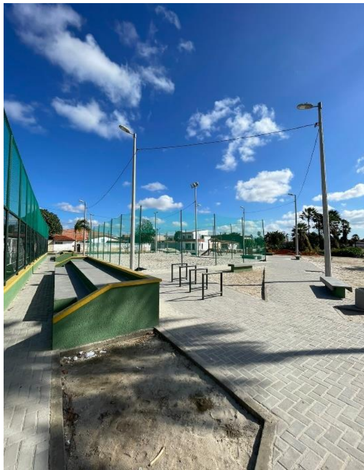
Pavimentação dos passeios piso intertravado
