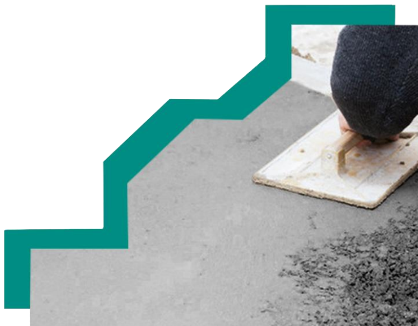
FIGURA 22. Passeio público com concreto moldado in loco .
