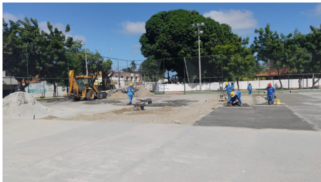
OBRAS DE URBANISMO
