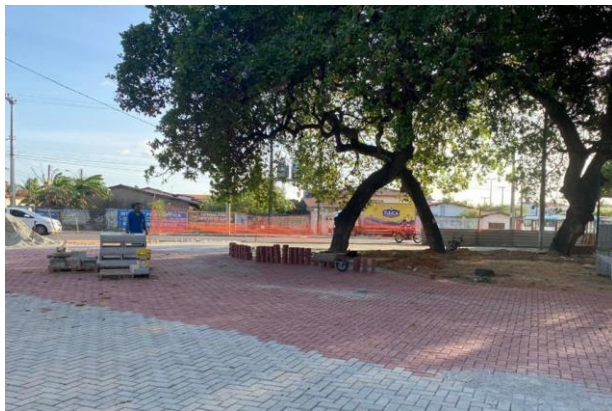
OBRAS DE URBANISMO
