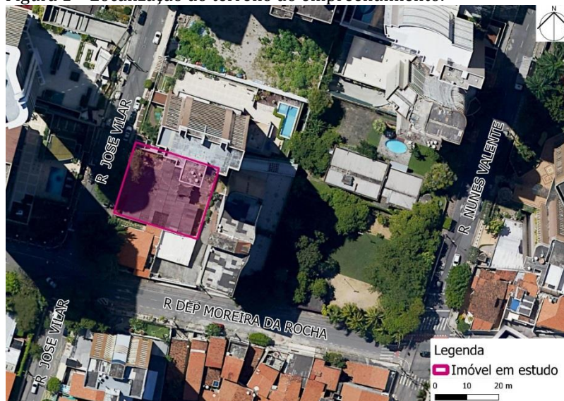
Figura 1 – Localização do terreno do empreendimento.
