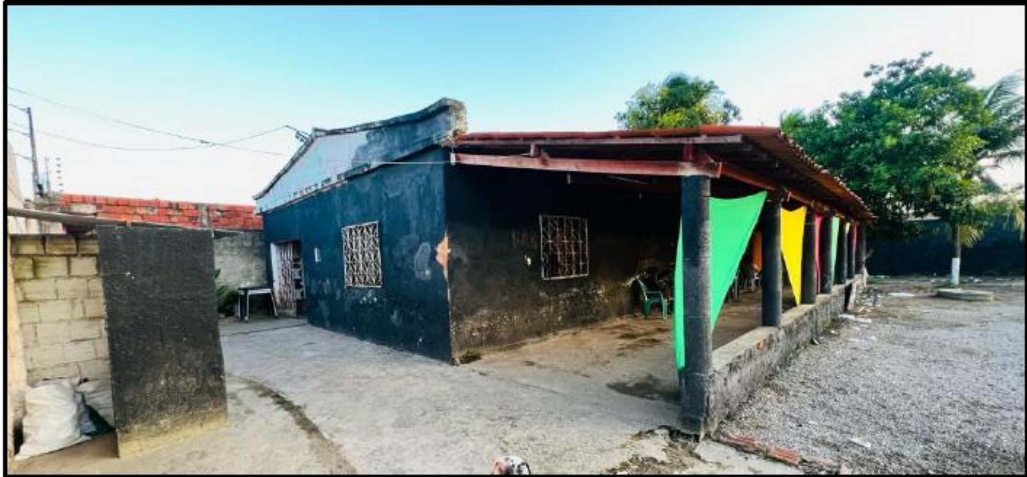
Figura 7 – Área Interna do Ambiente (01).
