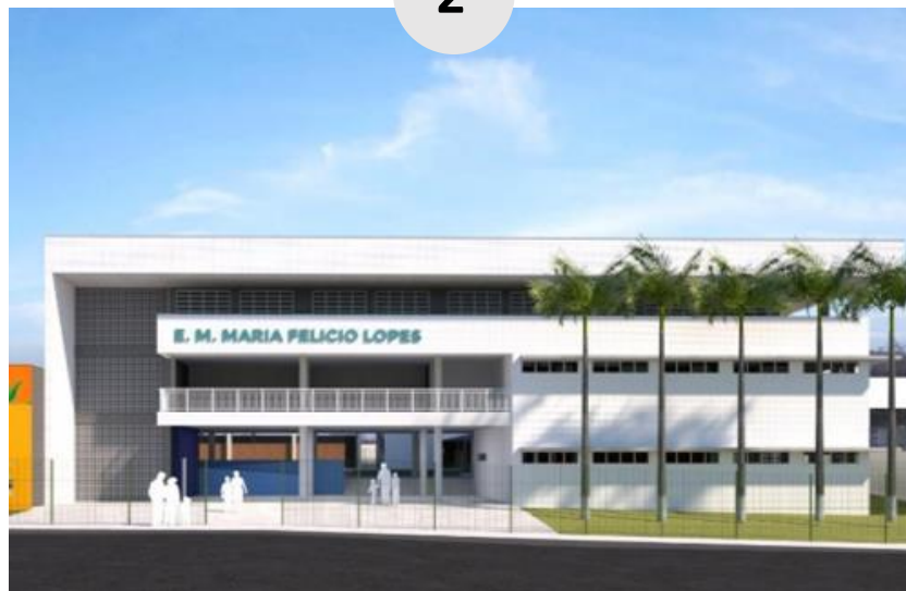
ESCOLA DE ENSINO FUNDAMENTAL (SERVIÇO DE EDUCAÇÃO)
