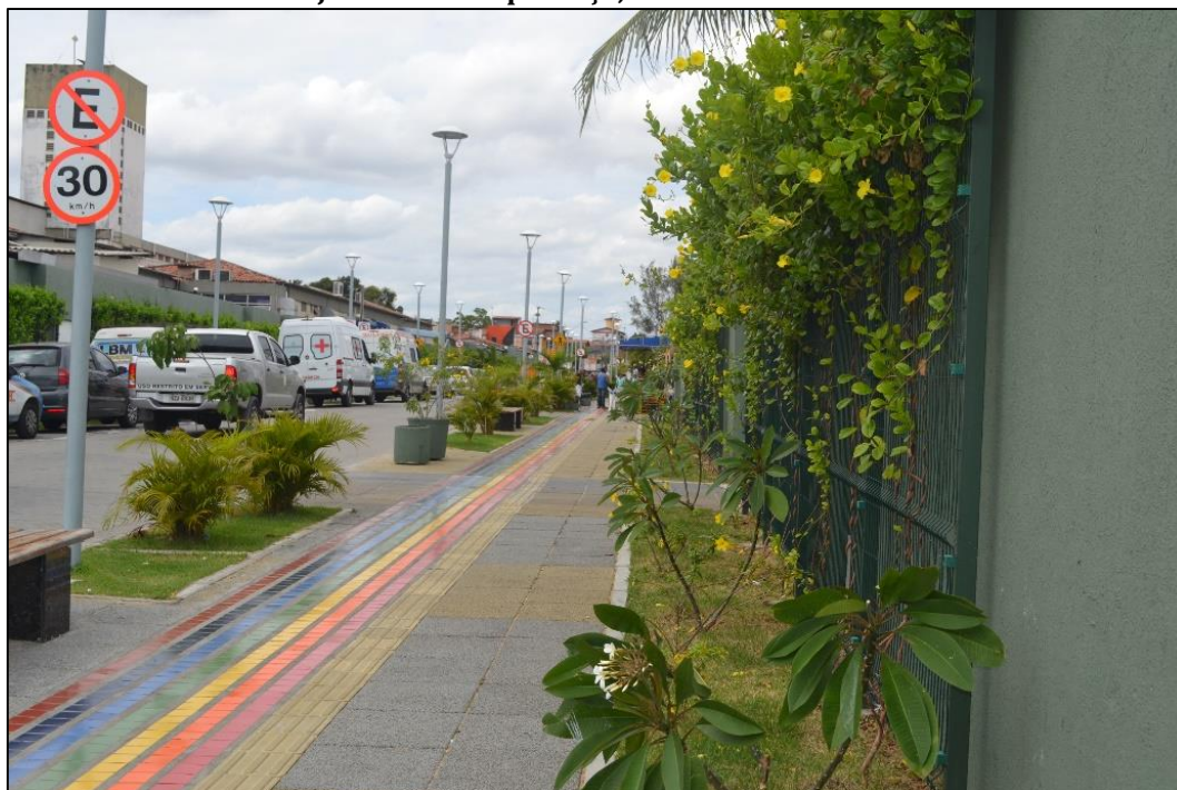
FIGURA 21 - Projeto Rua da Esperança, no bairro Vila União em Fortaleza.
