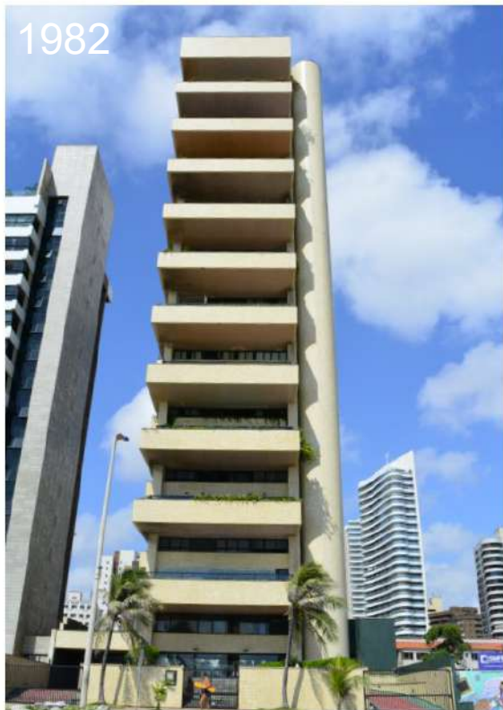
FIGURA 4.122 - Edifício Presidente Kennedy (1982) dos arquitetos Ione Felício Fiúza e Luiz Barbosa Fiúza
