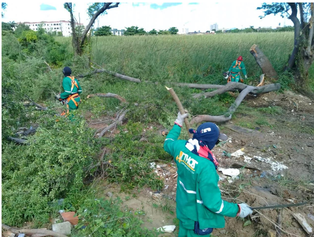
Registro fotográfico 05: Execução da limpeza de terreno.
