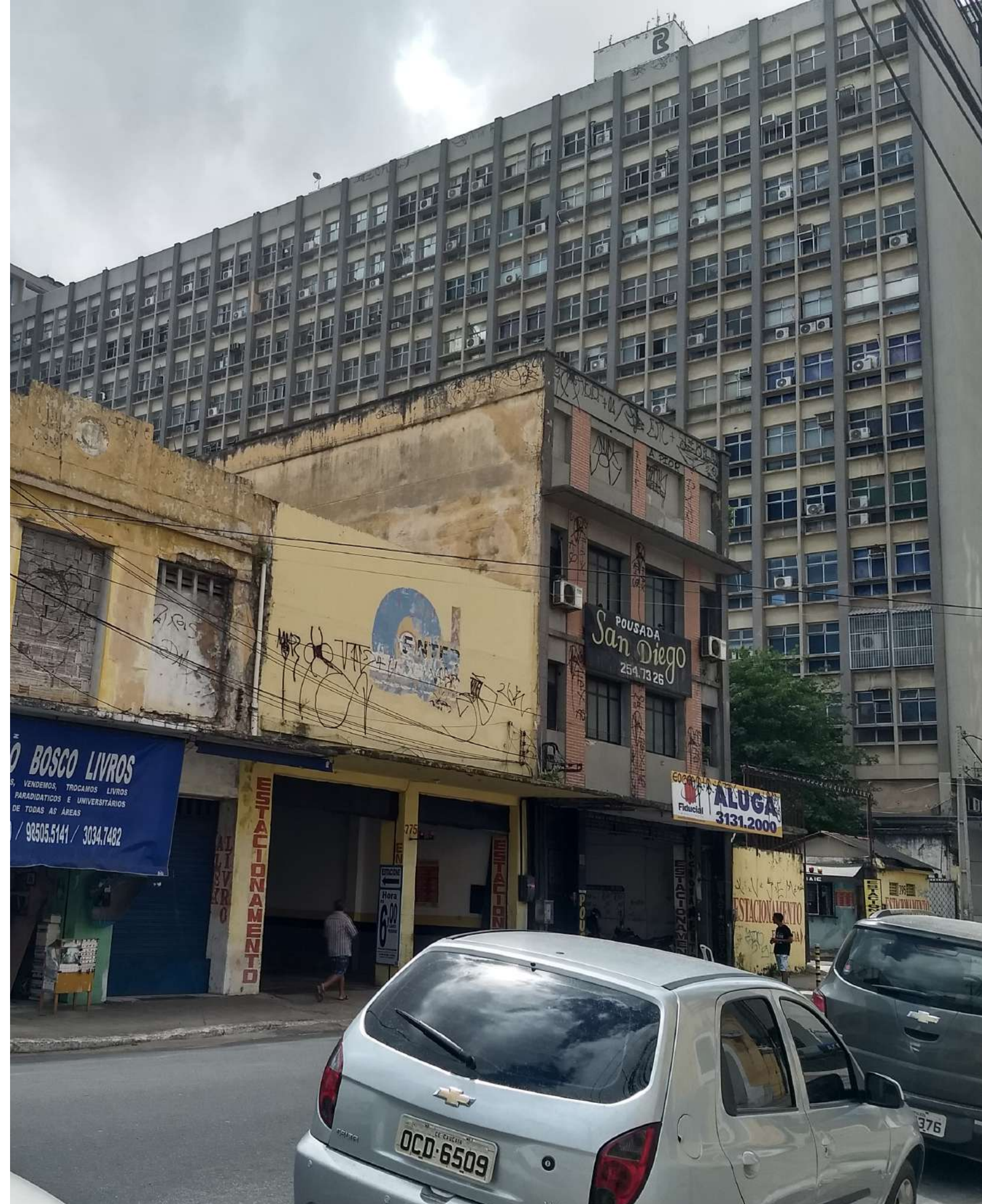
FACHADA DOS TERRENOS ATUALMENTE
