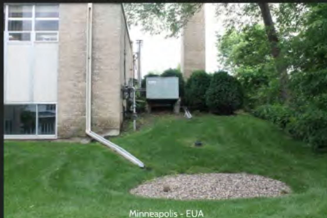
TRINCHEIRAS OU POÇOS DE INFILTRAÇÃO
