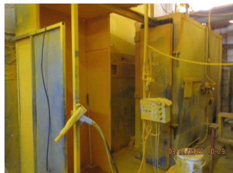
Cabine de pintura
